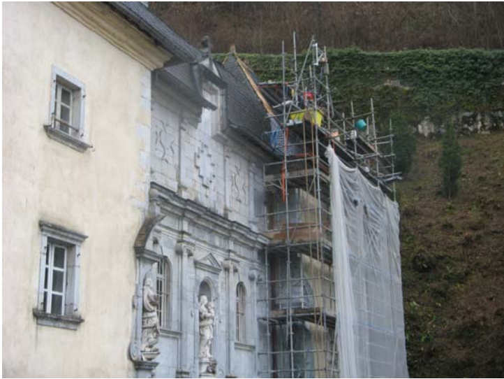
Restauration de la façade de la Chapelle Notre-Dame
