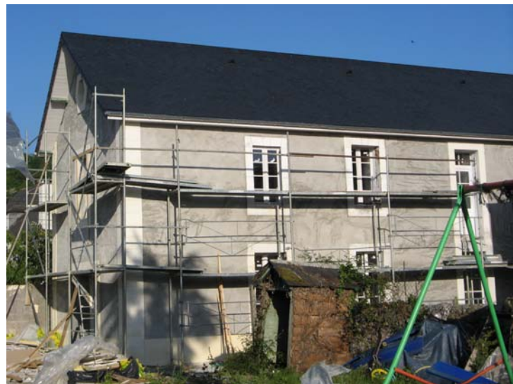
Réhabilitation 15 rue Gaston de Foix par le PACT du Béarn
