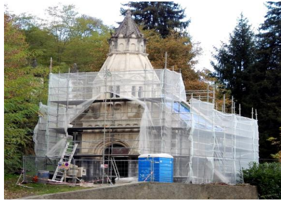
Démarrage de la rénovation du calvaire
