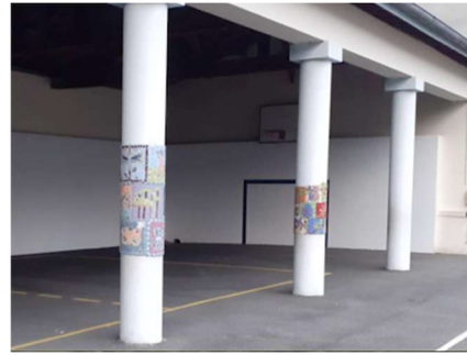
Les mosaïques du préau de l'école à terminer
