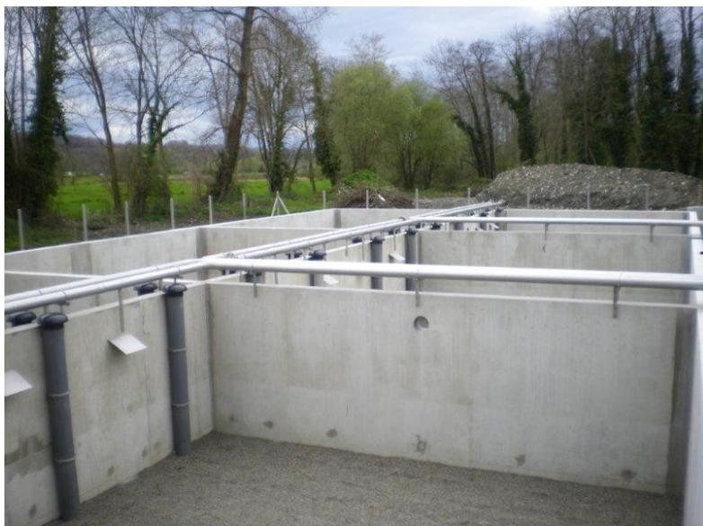
La station dispose de six bassins qui sont alimentés en alternance (une semaine sur deux) pour permettre un développement optimal du processus épuratoire. Chaque bassin est alimenté en plusieurs points au-dessus de la surface, de manière à obtenir une répartition homogène de l'effluent sur le bassin.
